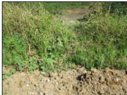
รูปที่ 2-11 คันทำนบดินรอบพื้นที่ทำเหมืองและการปลูกพืชคลุมดิน
